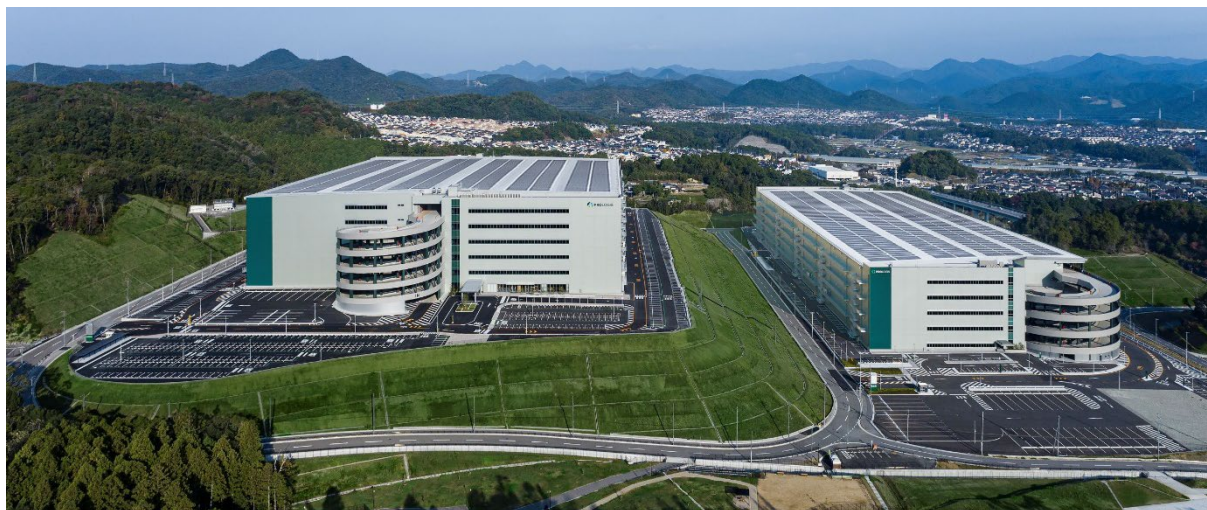
電力グリーン化を行った「プロロジスパーク猪名川 1」(左)／「プロロジスパーク猪名川 2」(右)も今後実施予定
