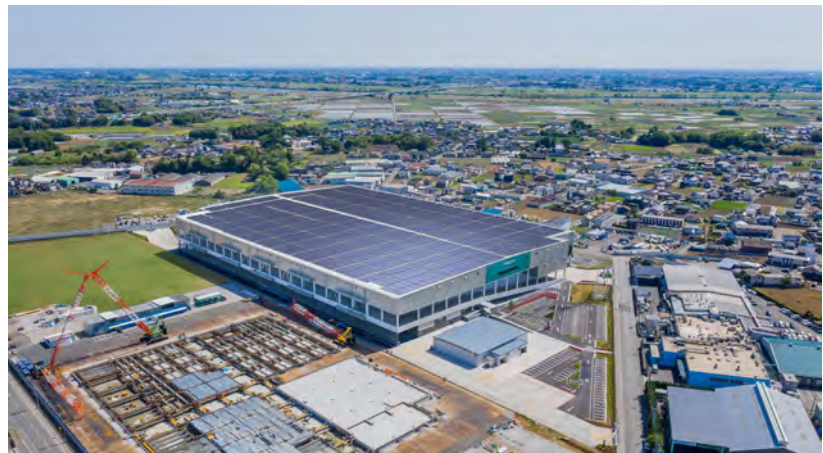
小型倉庫側からの鳥瞰
