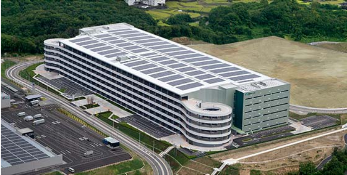
屋根面に2メガワットの太陽光発電パネルを設置した「プロロジスパーク茨木」
