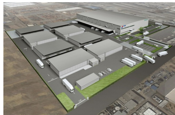
危険物倉庫8棟(手前)と「プロロジスパーク古河2」
